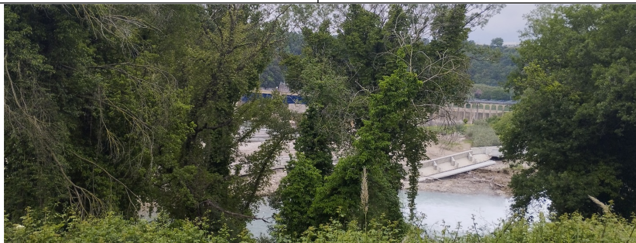
Passaggio per pesci demolito dalla piena presso la diga di Persano
